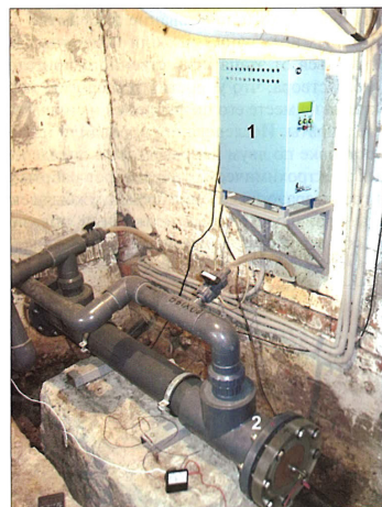
Рис. 1. Производственная электролизная установка 1 – блок питания постоянного тока с возможностью реверса; 2 – проточный электролизер
