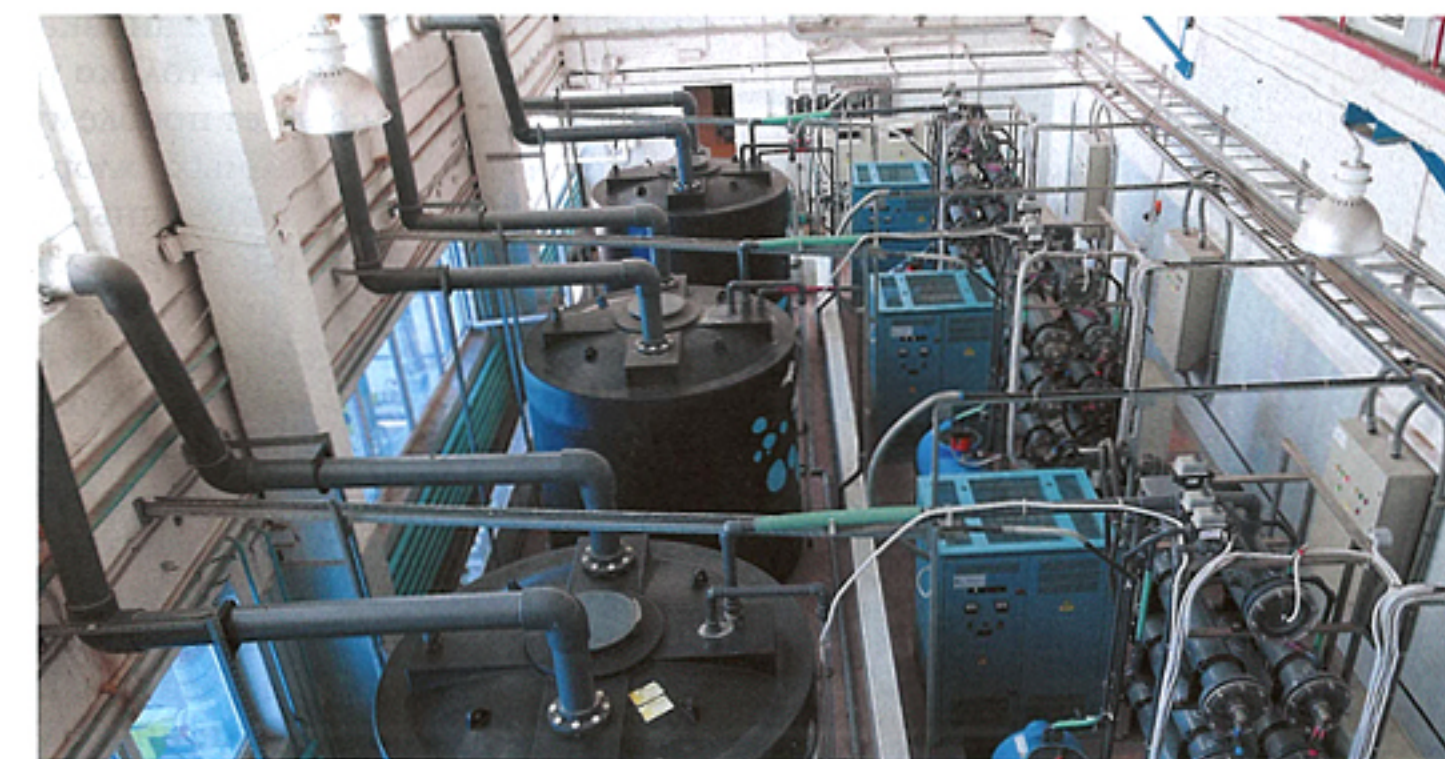
Рис. 2. Четыре электролизных установки «Хлорэфс» УГ-25МК-250 производительностью 250 кг/сут по активному хлору каждая для обеззараживания питьевой воды (г. Ростов-на-Дону)
